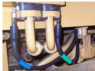
3 Az emelő dugattyú hidraulikus körébe épített olajnyomás érzékelők.
